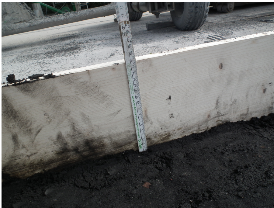
Abbildung 5-11: Gießereialsand-Braunkohlenflugasche-Grundsicht (Höhe 23 cm)
