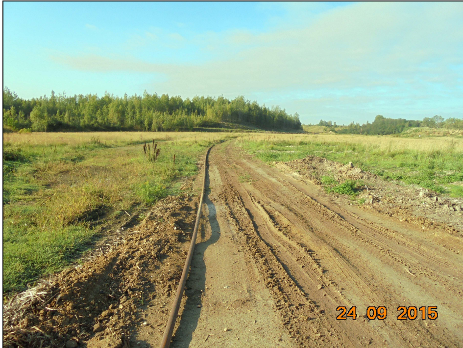
Bild 3: verlegte Versatzleitung
