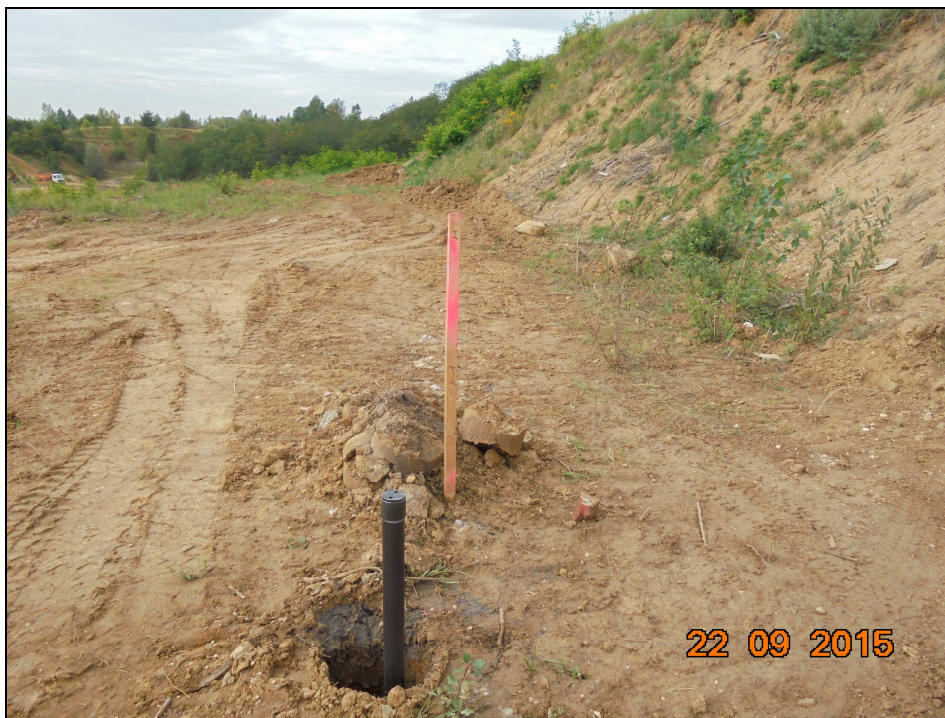
Bild 14: RB I/15 – eingebauter Riegelsack
