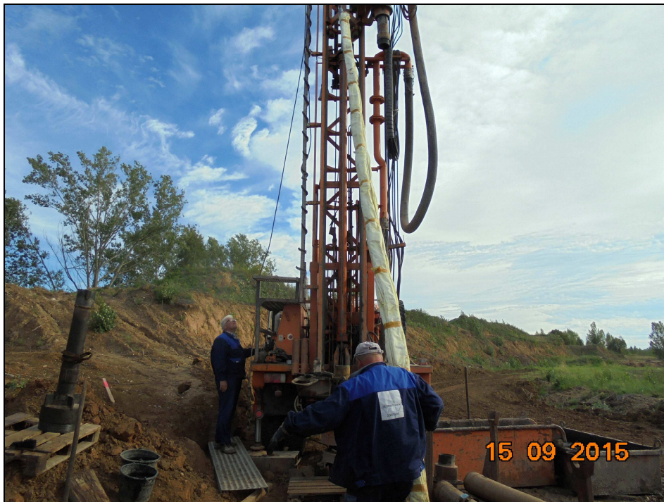
Bild 15: RB II/15 – Einbau Riegelsack
