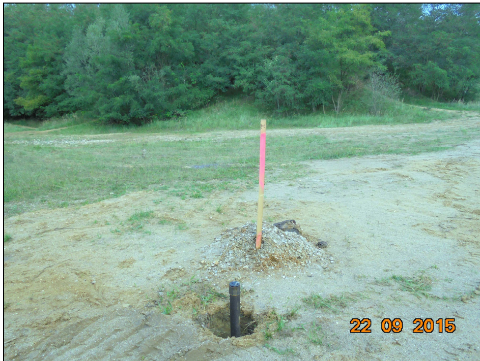
Bild 17: RB V/15 – eingebauter Riegelsack
