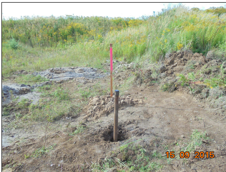
Bild 18: RB VI/15 – eingebauter Riegelsack
