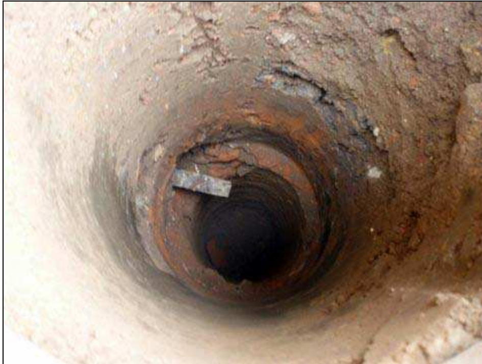
Bild 5: VB 12/15 – durchbohrter Stahlträger
