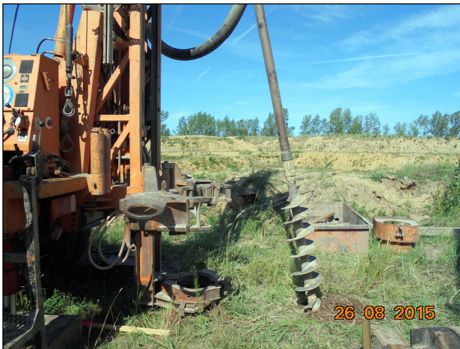
Bild 4: VB 11A/15 – Vorbohrung für Standrohr
