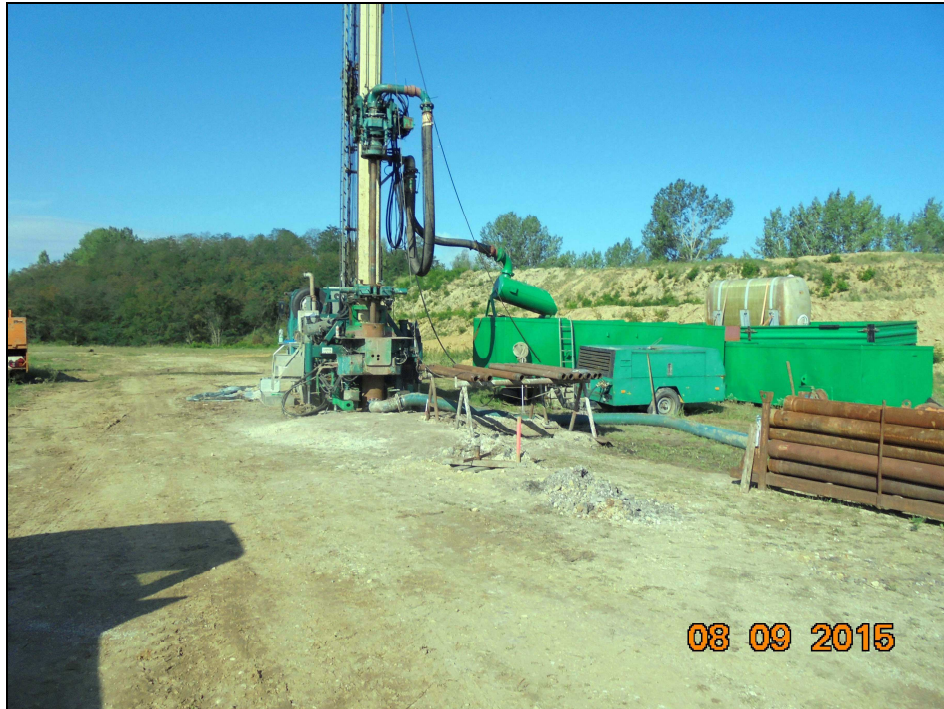
Bild 1: Bohrarbeiten am Brunnen
