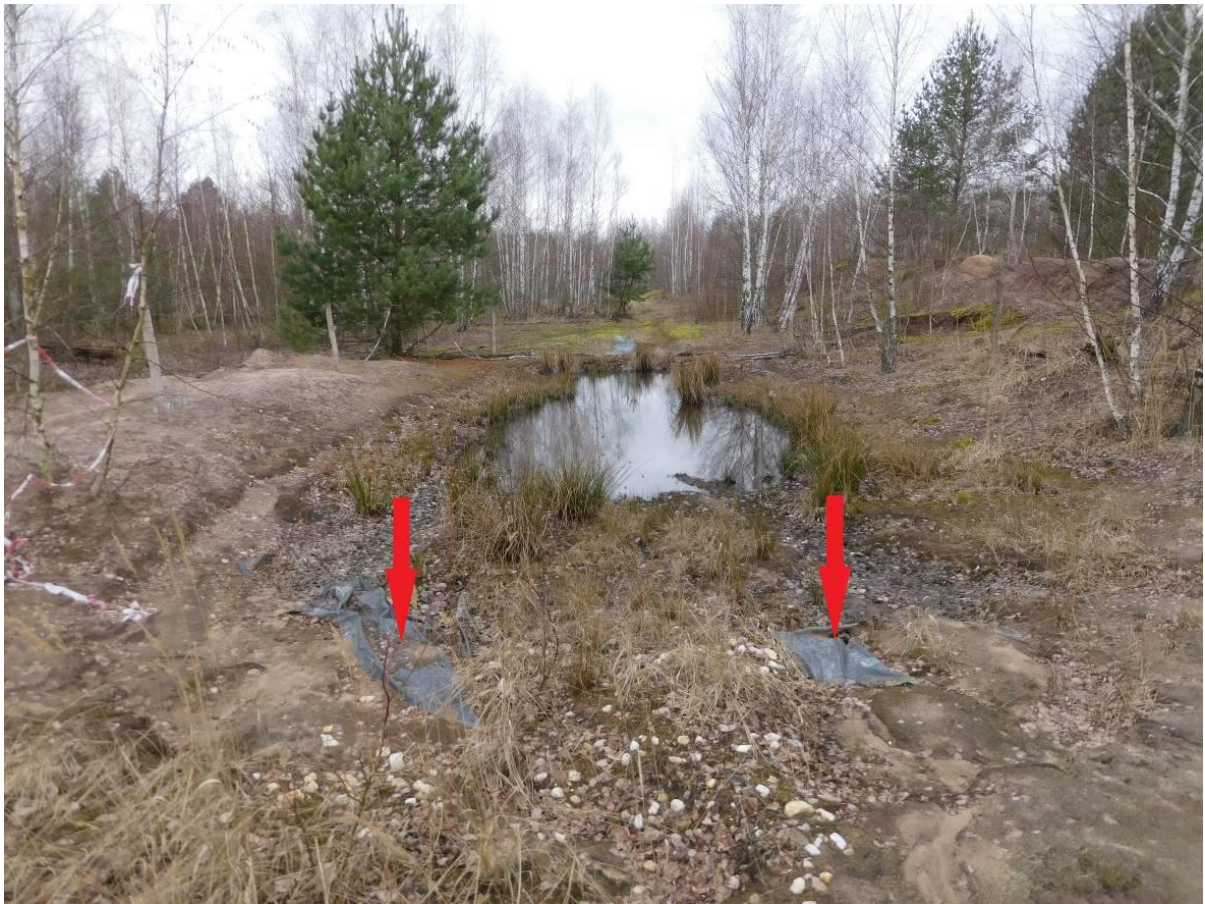
Foto Nr. 111: Gewässer 4 mit beschädigter Foliendichtung
