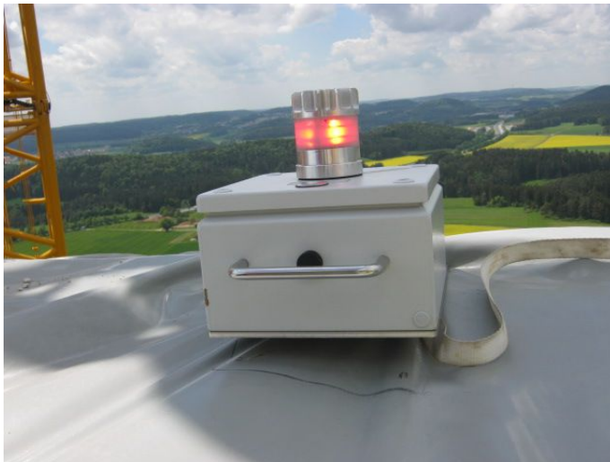
Abb. 3: Befeuerung bei aufgesetzter Stahlsektion
